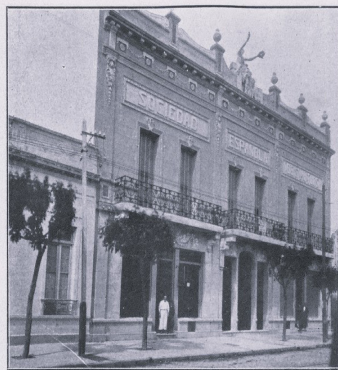
Vista del edificio, cuya inauguración se llevó a cabo el sábado
